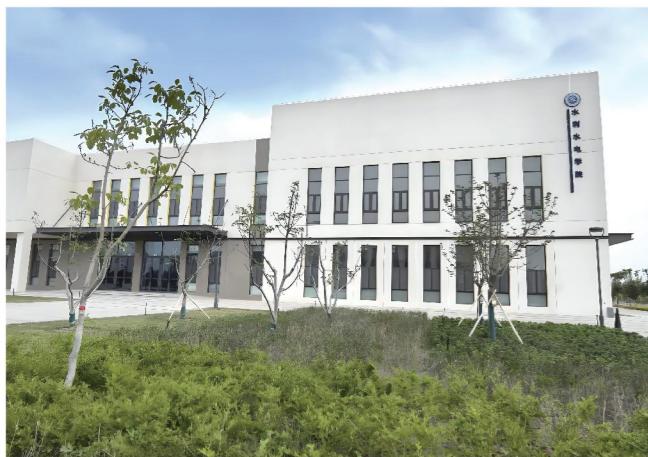
教学楼与实验楼外观
